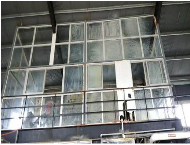
污泥脱水间负压集气密封
