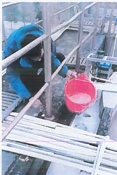
附图 1 现场检测照片
