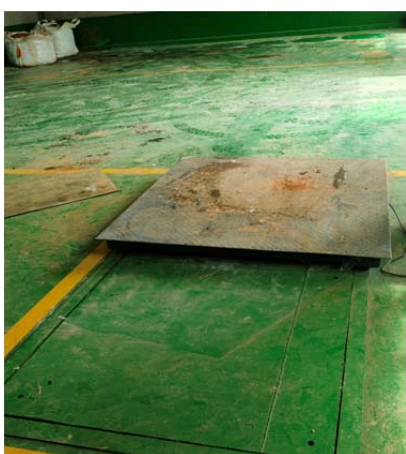
危废暂存间废水收集池
